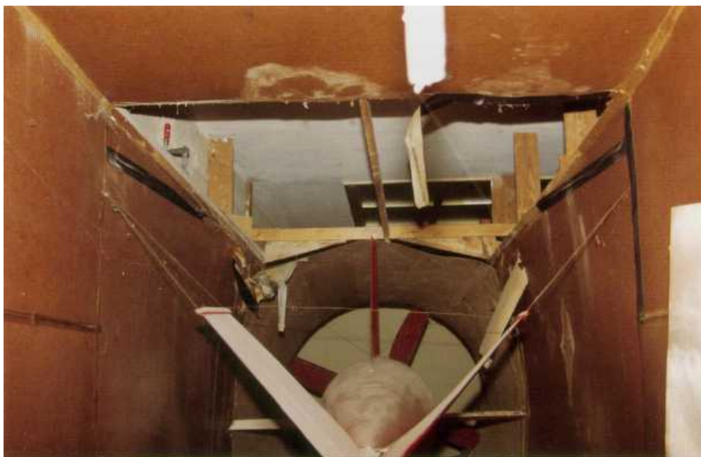
Blick in den Langkanal auf den Rotor vor der Renovierung
