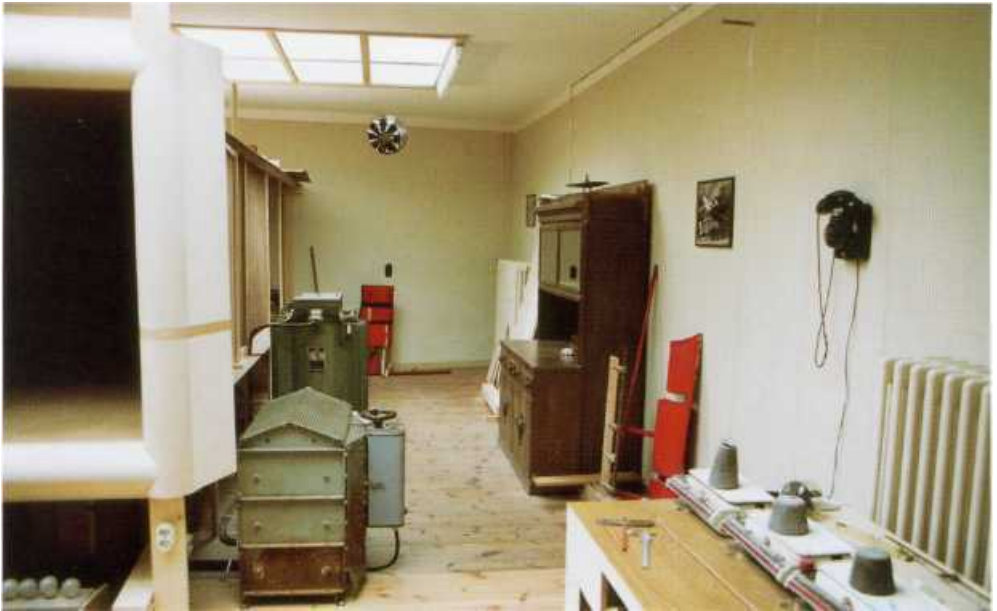
Blick in die Halle nach der Renovierung
